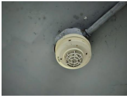
เครื่องตรวจจับความร้อนห้องเครื่องไฟฟ้า
