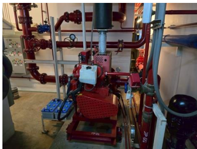
เครื่องสูบน้ำดับเพลิงชั้นใต้ดิน-ชั้น 19
