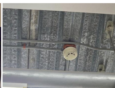
เครื่องตรวจจับควันภายในห้องเครื่องไฟฟ้า
