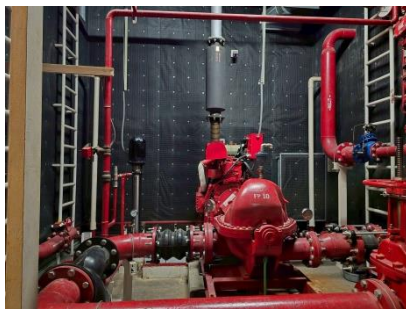
เครื่องสูบน้ำดับเพลิงชั้น 20-ชั้นดาดฟ้า
